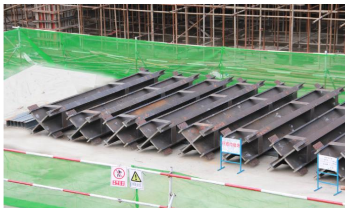
图 5.7.2-1 钢柱堆放示意图
