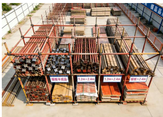
图 4.4.1-1 周转架料堆放示意图
