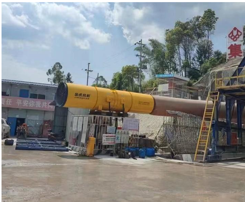
图 5.12.1-1 隧道通风机设置示意图
