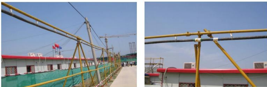
图 5.3.4-4 架空敷设实景图
