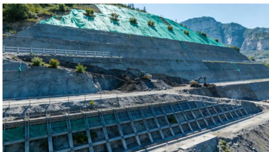
图 5.10.3-1 边坡防护示意图
