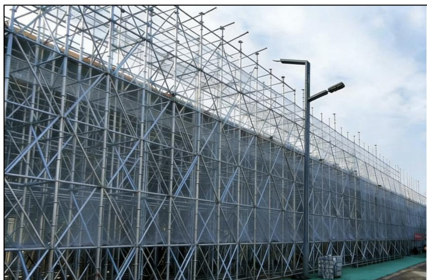
图 5.5.3-1 盘扣式脚手架搭设示意图
