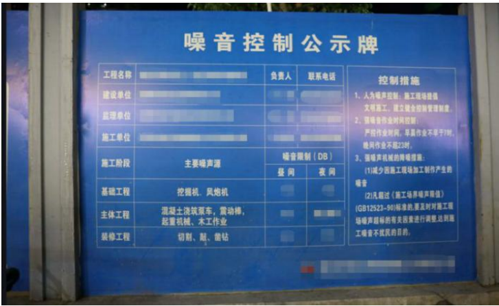
图 8.2.2-1 夜间施工公示牌张贴图
