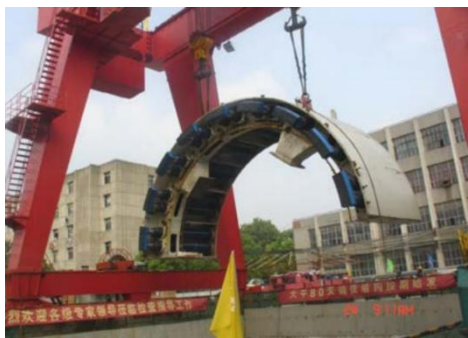
图 5.12.2-1 盾构中体下井示意图
