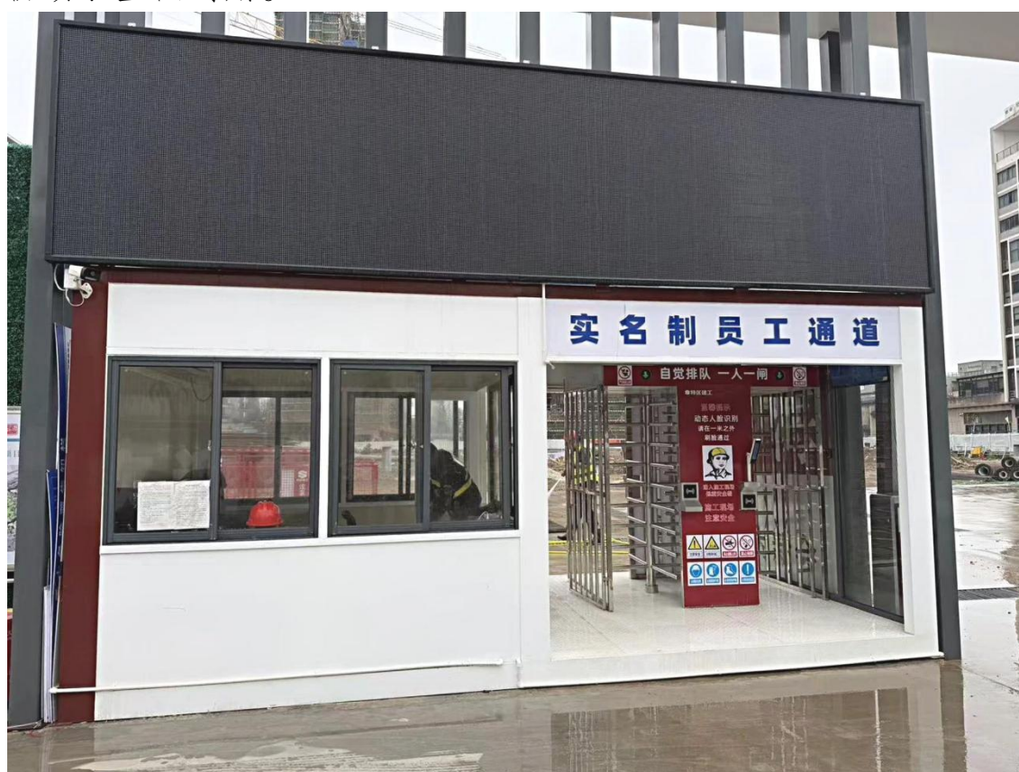
图4.1.3-1 箱式门禁系统实景图
