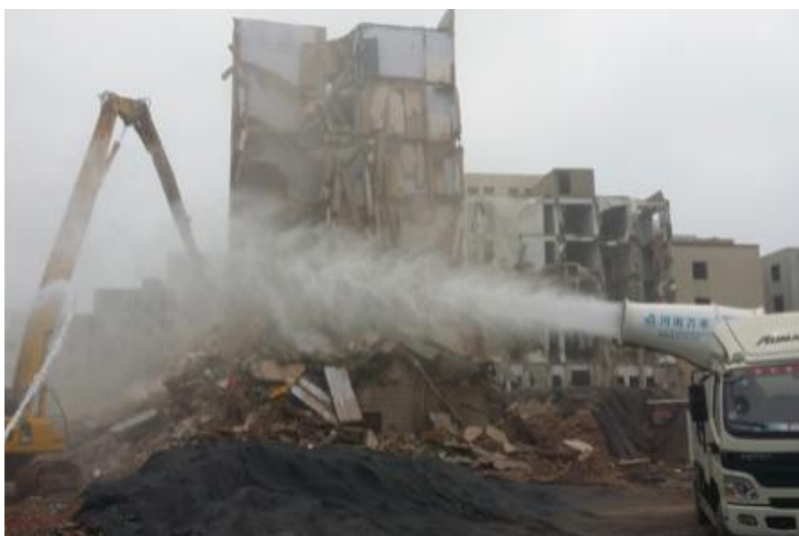
图 8.1.4-3 拆除作业全程喷淋降尘图
