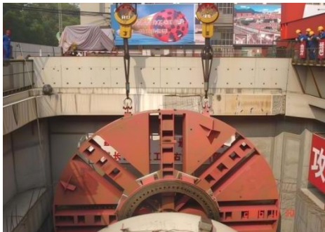
图 5.12.2-3 盾构刀盘下井示意图
