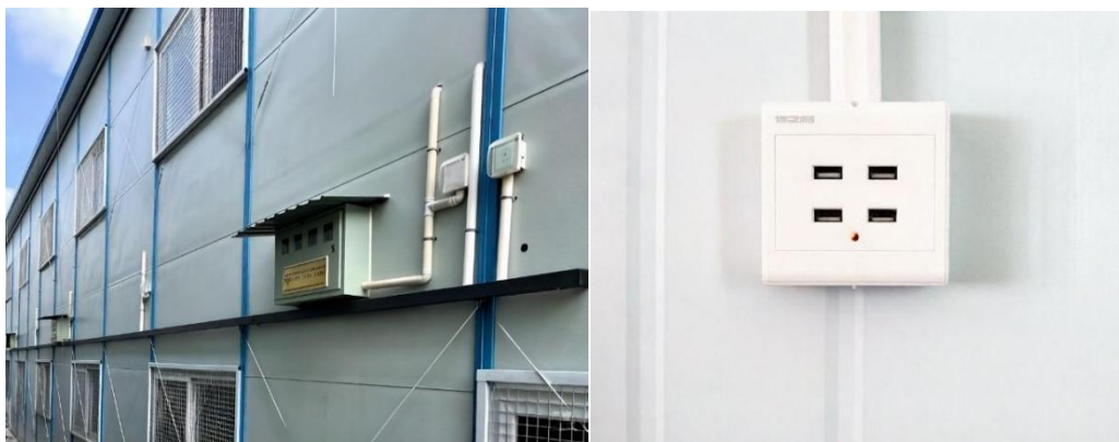
(a) 空调线路敷设于临时用房外侧 (b) 36V USB 充电接口
