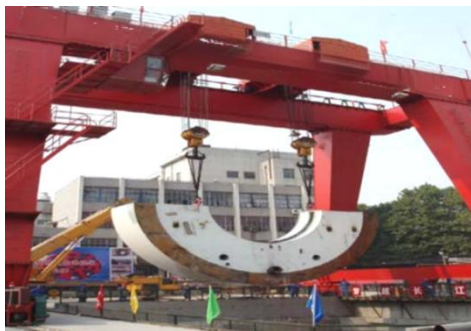
图 5.12.2-2 盾构前体下井示意图
