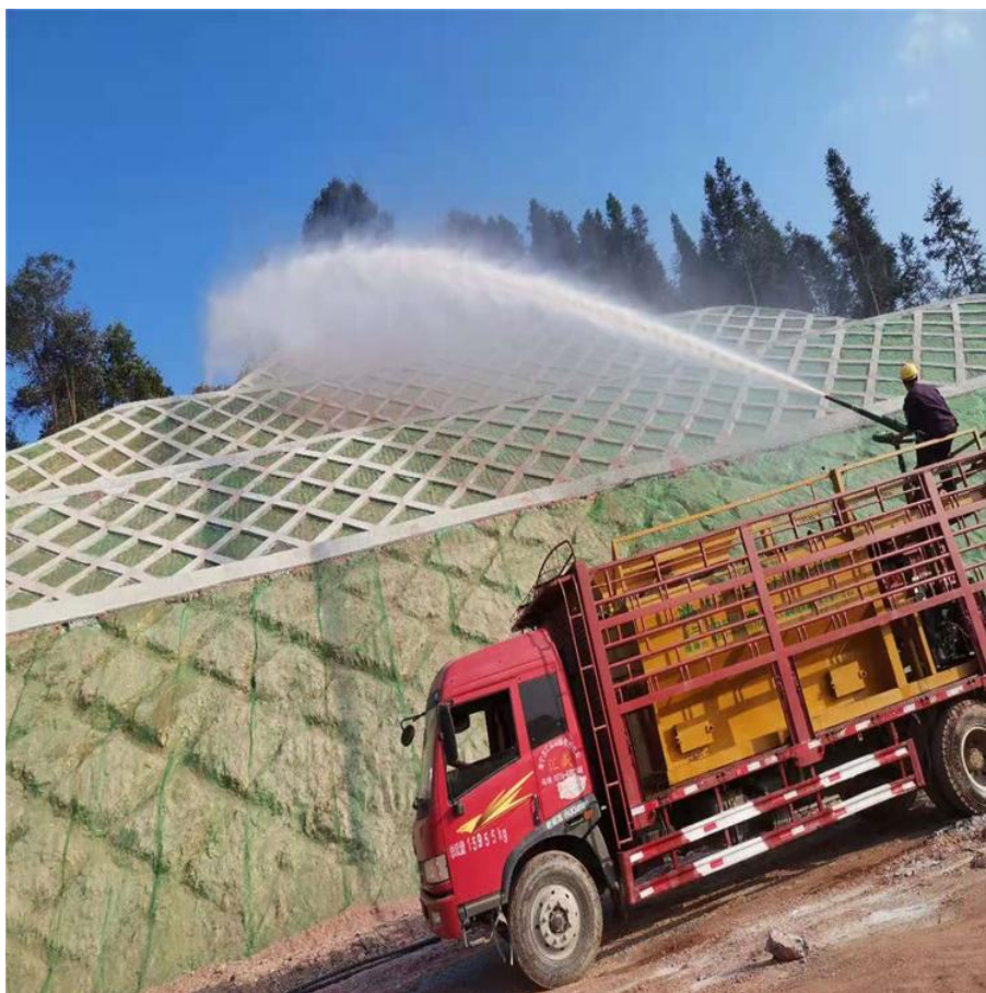
图 8.6.3-1 植被绿化喷播机作业示意图
