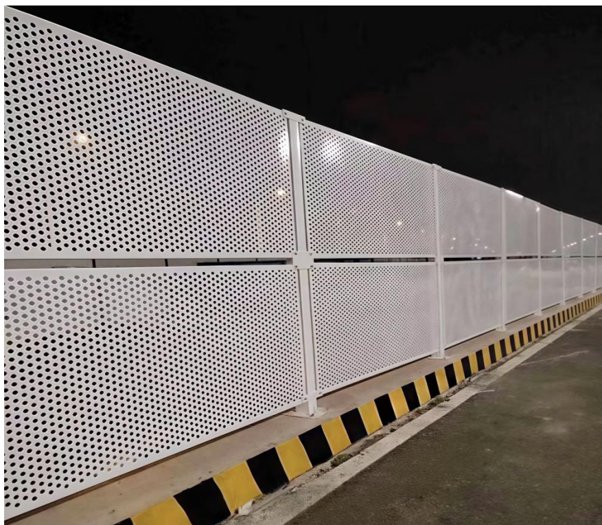
图 4.1.4-6 装配式金属穿孔板围挡效果示意图
