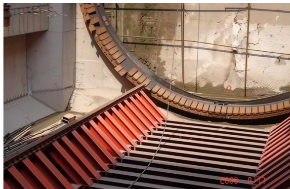
图 5.12.2-7 始发基座示意图
