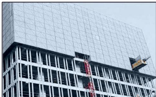
图 5.5.5-3 自爬升悬挑卸料平台示意图
