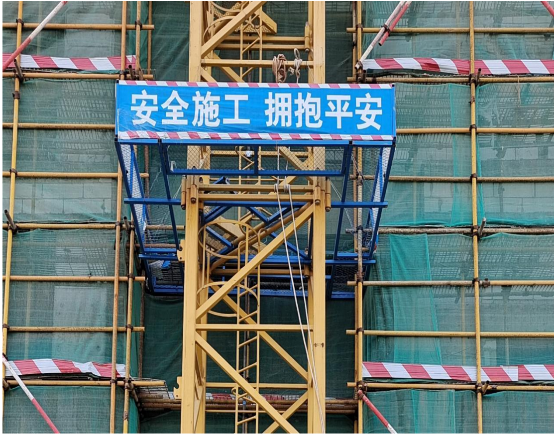
图 5.2.1-2 塔式起重机防攀爬措施示意图
