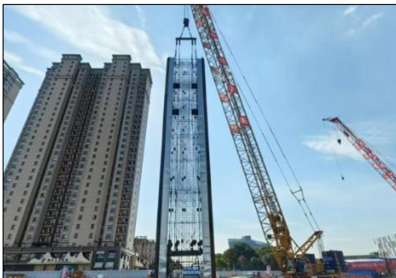
图 5.4.6-1 钢筋笼吊装示意图
