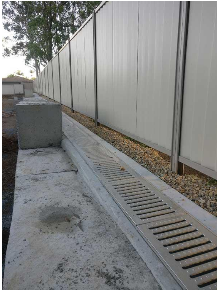
图 8.6.2-1 施工区周边混凝土排水沟实景图
