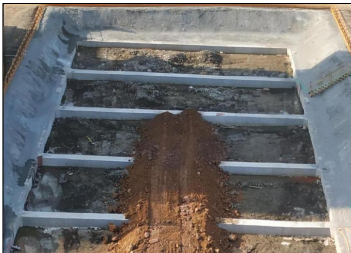
图 5.4.4-1 钢筋混凝土支撑示意图
