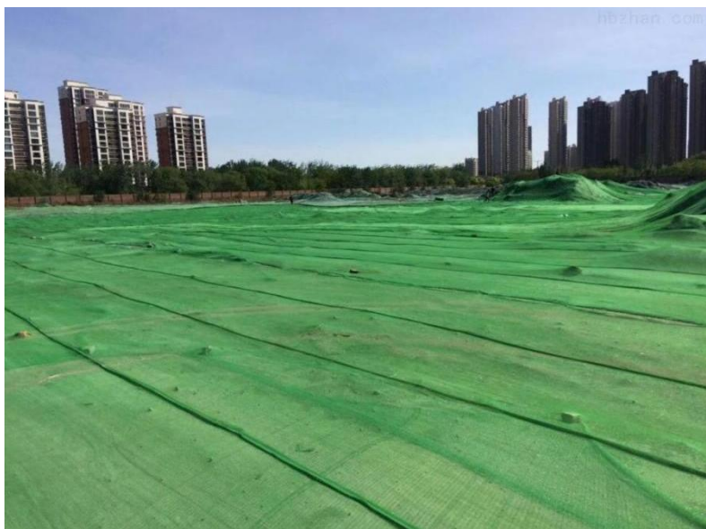
图 8.1.3-1 绿网覆盖砂土堆实景图
