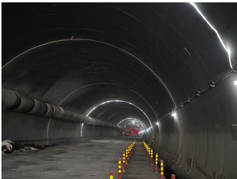
图 5.12.1-11 人车分流示意图
