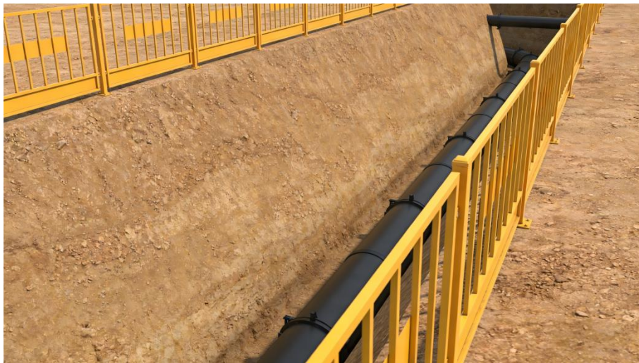
图 5.10.5-1 沟槽开挖示意图
