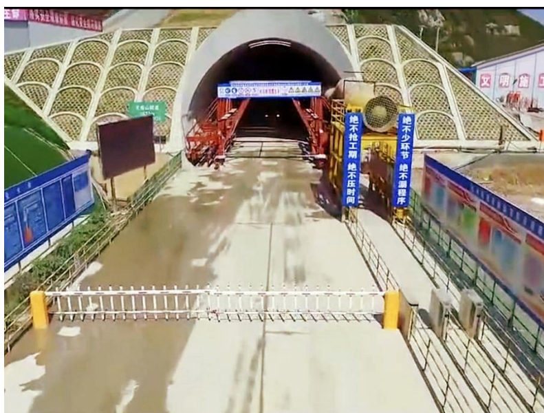
图 5.12.1-2 隧道洞口设置门禁系统示意图
