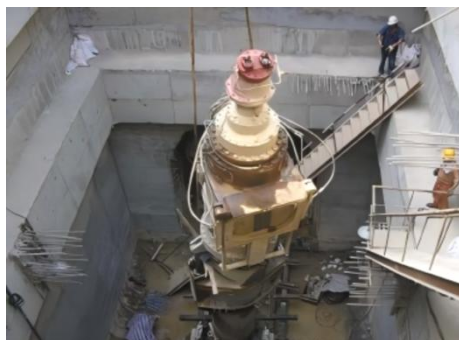
图 5.12.2-6 螺旋输送机下井示意图
