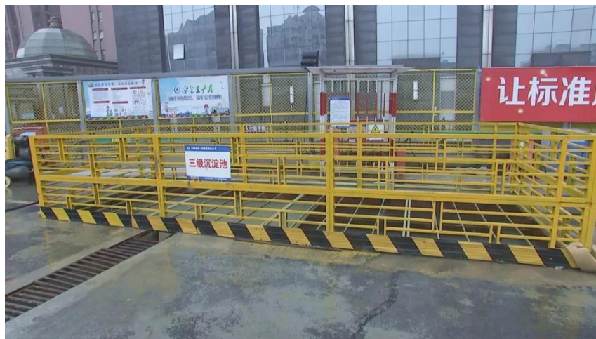
图 8.3.2-1 三级沉淀池实景图
