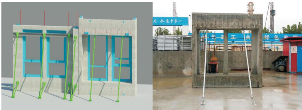
图 5.8.4-1 PC 构件临时固定示意图
