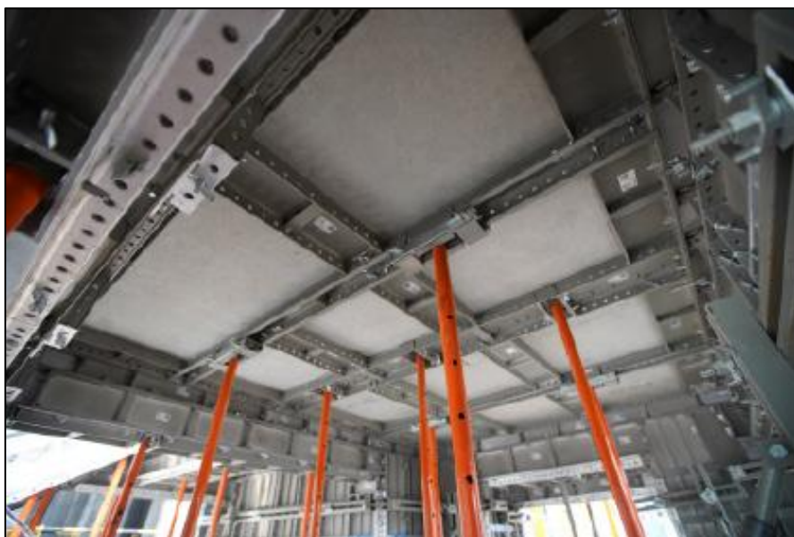
图 5.6.5-1 铝膜拼装示意图
