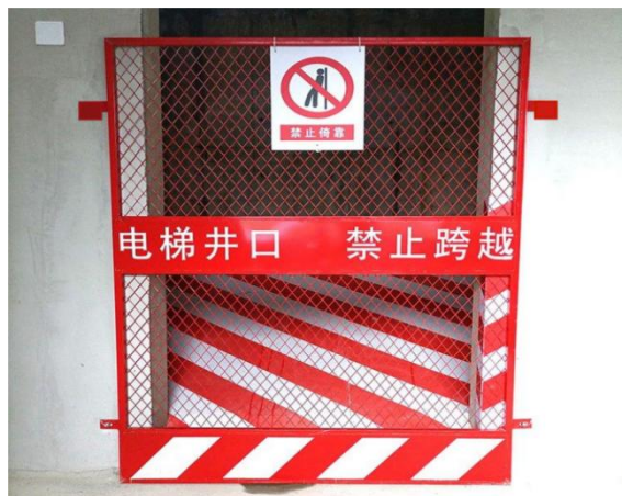
图 5.9.3-1 室内电梯井口防护示意图
