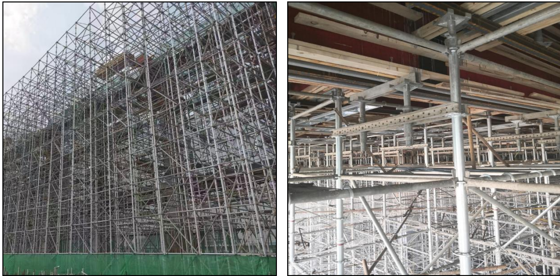
图 5.6.4-1 盘扣式支撑体系示意图
