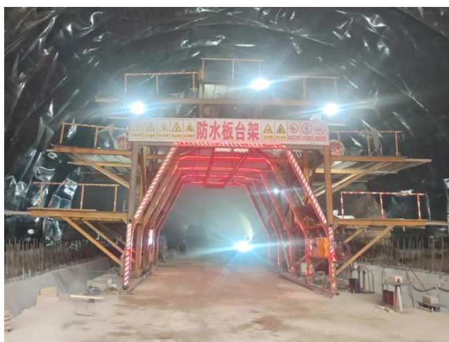
图 5.12.1-10 防水板台架安装
