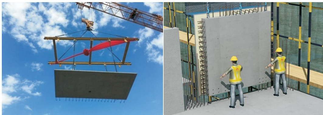
图 5.8.3-1 PC 构件吊装示意图
