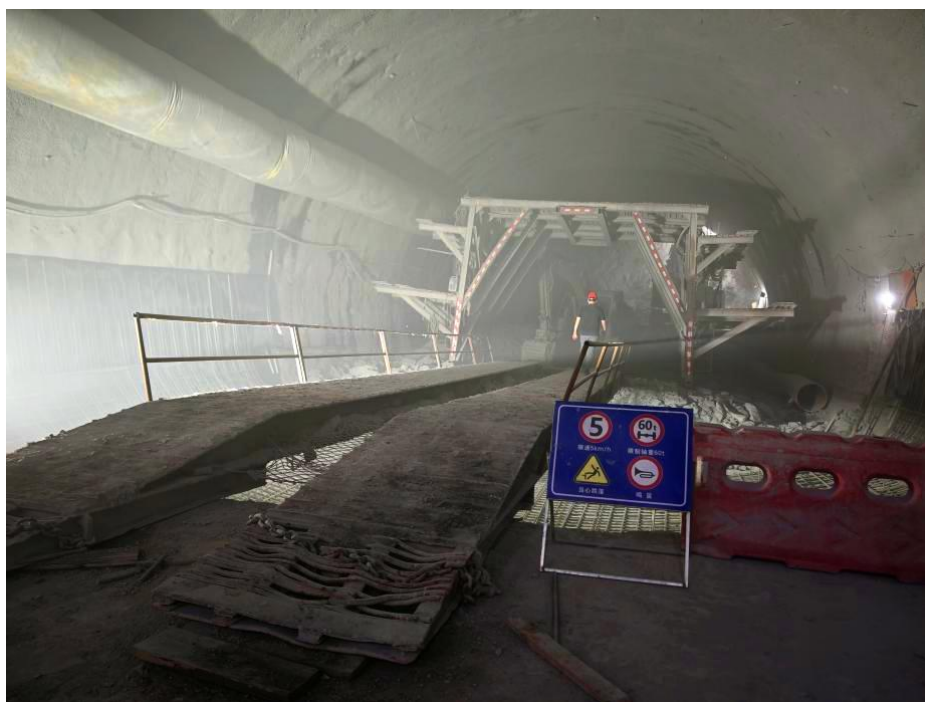
图 5.12.1-8 仰拱栈桥示意图
