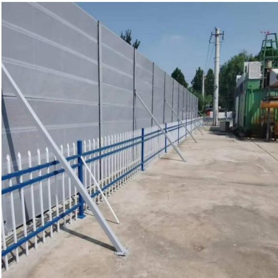
图 8.2.2-2 工地边界隔声屏障设置图
