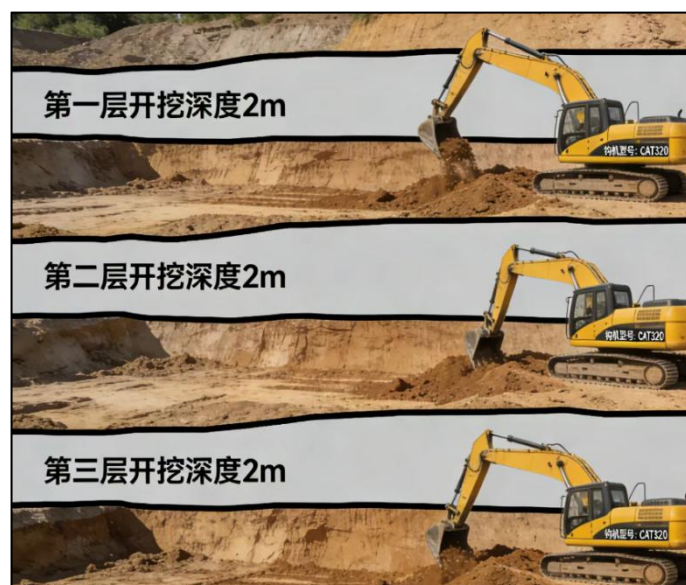
图 5.4.8-1 分层开挖示意图
