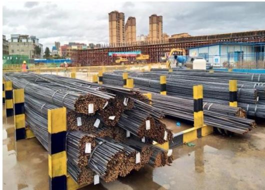
图 4.4.1-4 钢材堆放示意图
