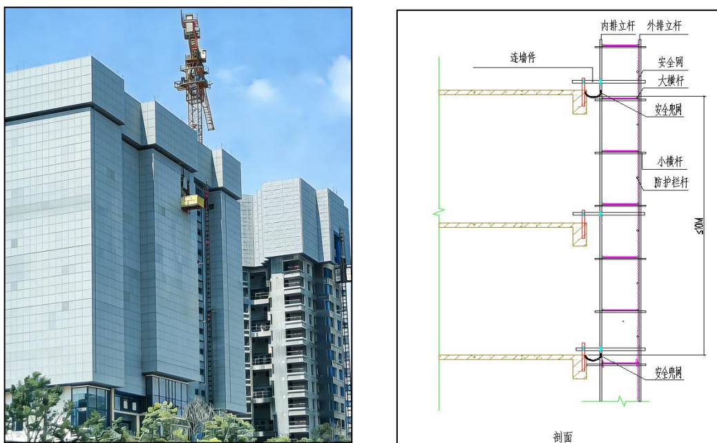
图 5.5.1-1 冲孔金属网示意图
