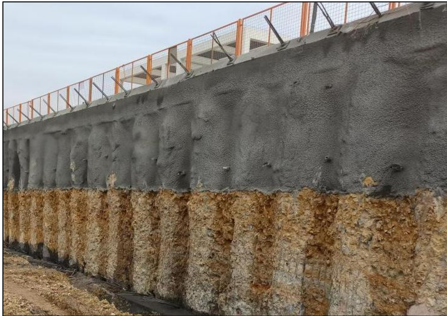
图 5.4.3-1 桩锚支护示意图
