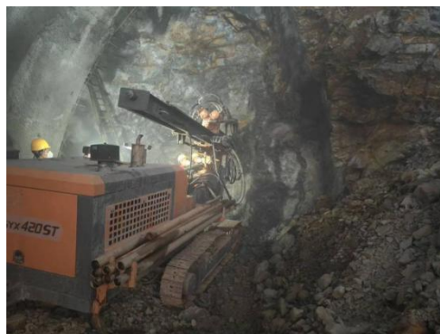
图 5.12.1-4 超前水平钻探测
