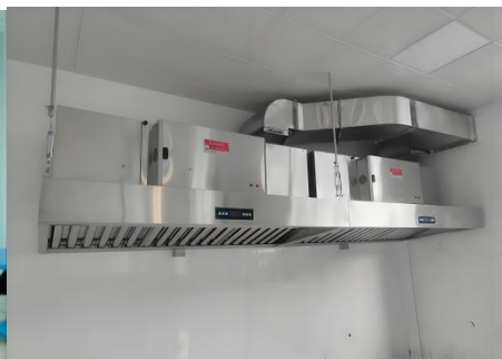
图 7.2.1-1 食堂布置示意图 图 7.2.1-2 油烟净化装置示意图
