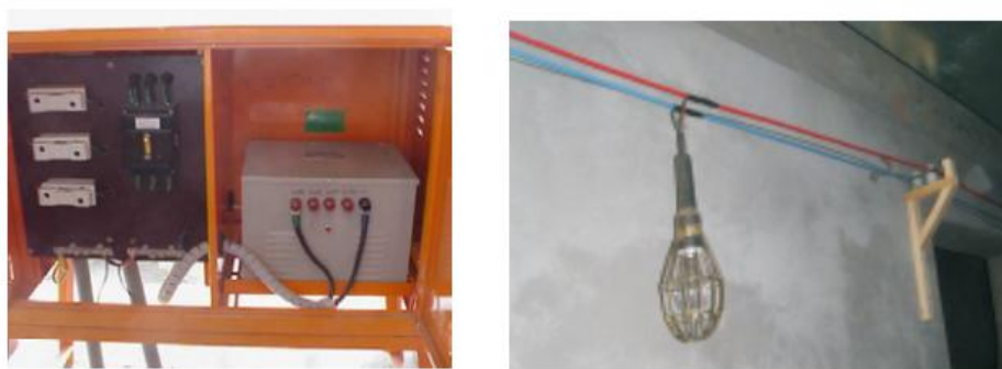
图 5.3.9-2 开关箱及低压照明灯示意图
