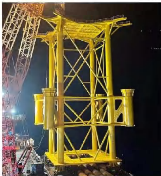
图 3.5.1-3 工艺定位架示意图
