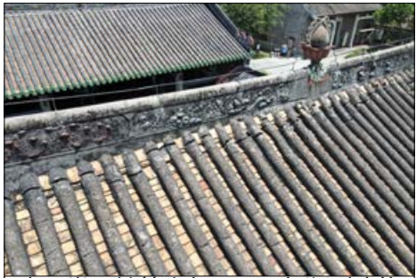
春阳堂—檐筒裹灰瓦面局部断裂移位
