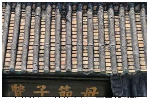
贞节牌坊—檐筒裹灰瓦面局部断裂
