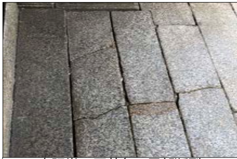
春阳堂—天井条石局部断裂
