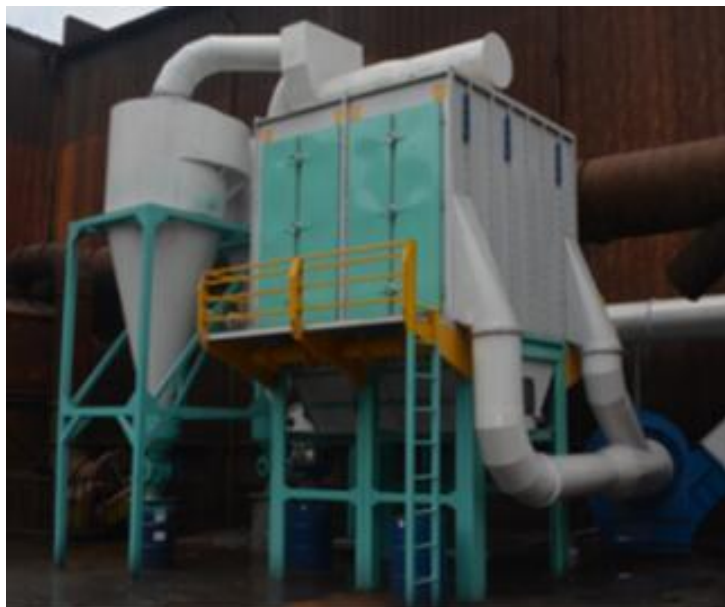
图 7.1-2 干法破碎分选废气处理系统设计示意图（旋风除尘+布袋除尘）
