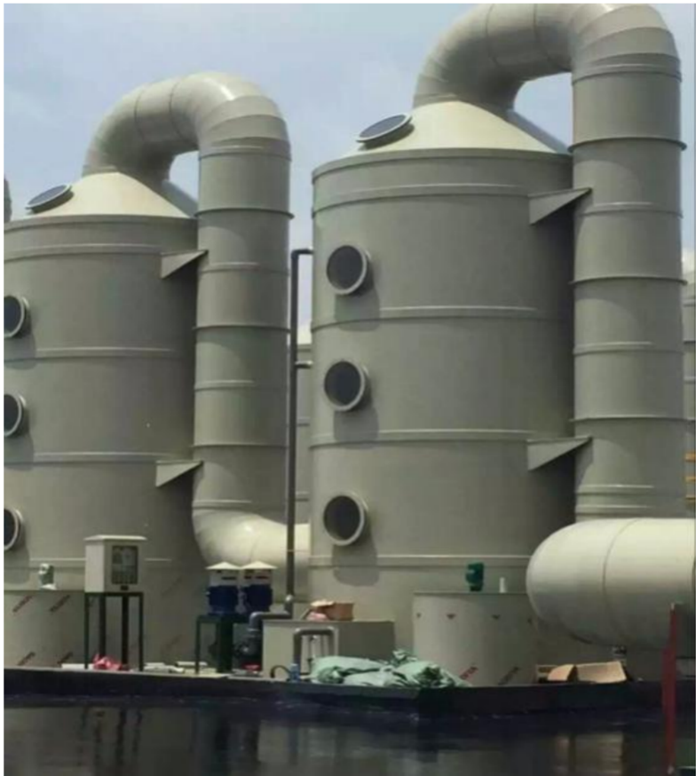
图 6.3-2 生物除臭塔装置图
