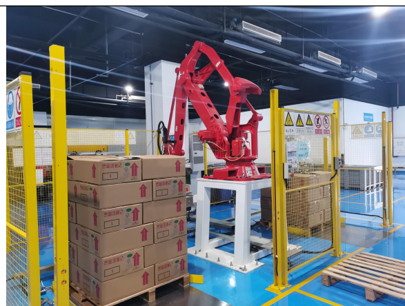
主厂房—包装车间（密闭车间）
