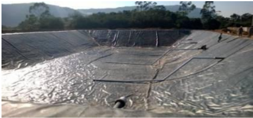
图 6.2-5 黑膜沼气池内部示意图
