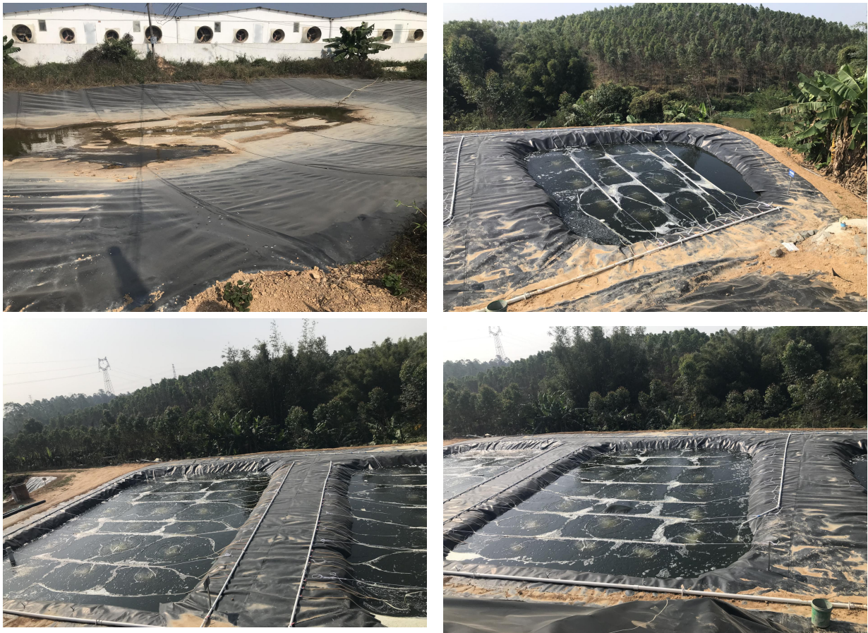
图 6.2-12 项目废水池防渗实景图
