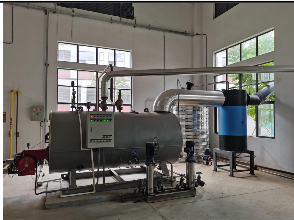
公用工程—锅炉房（蒸汽锅炉）
