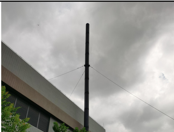
公用工程—蒸汽锅炉排气筒（DA004）
